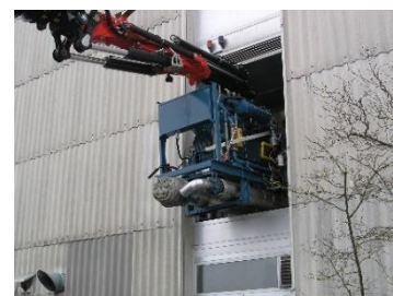
Abtransport altes BHKW
